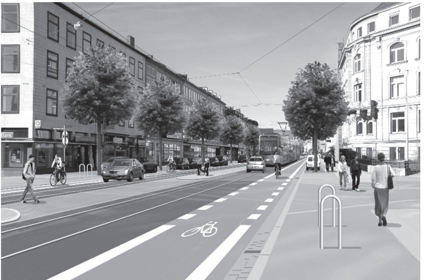
Simulation: die Straße nach dem Umbau im Ostabschnitt. Man erkennt links und rechts Baumreihen, breite Gehwege und Parkflächen zwischen den Bäumen. Es folgen Radfahr-Markierungen, Pkw-Fahrbahn / Schienenstrang, sowie in der Mitte eine Mittelinsel zur besseren Überquerung für Fußgänger.
